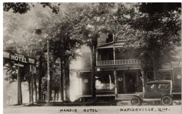
Figure 3 : Manoir Hotel, Napierville Source : Greenerpasture
